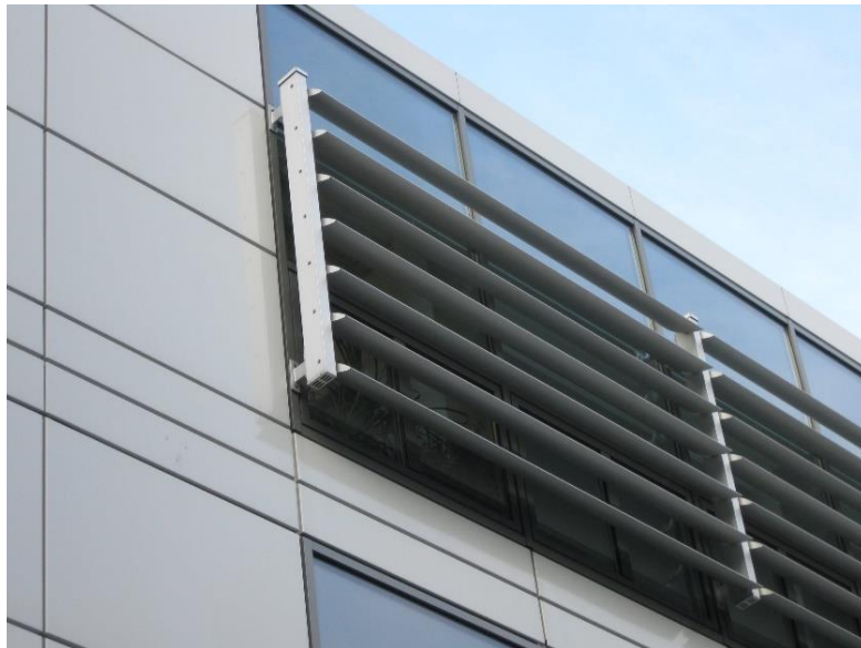
17. ábra: Forgólamellás homlokzati árnyékoló 25
