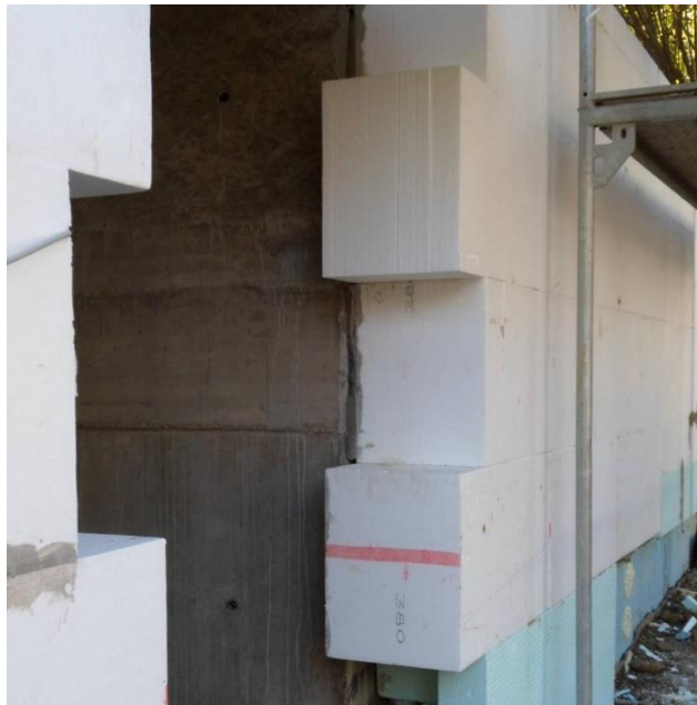
9. ábra: 38 cm vastag hőszigetelés homlokzaton 17
