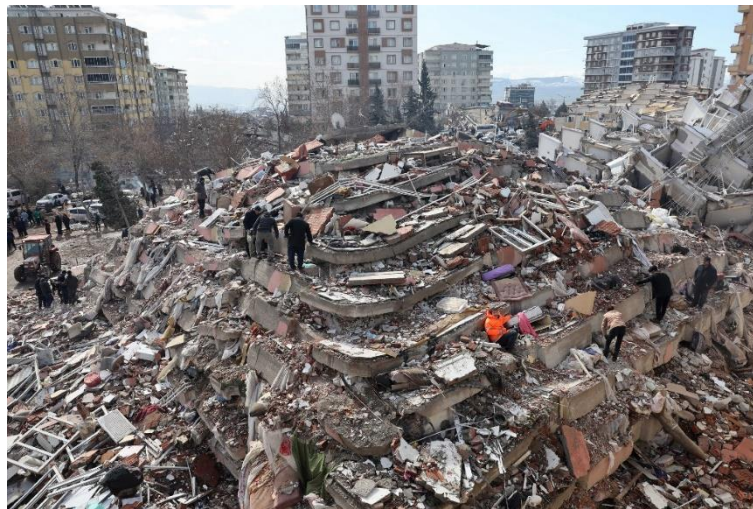
2. ábra: Kahramanmaras városban összeomlott épület [5]
