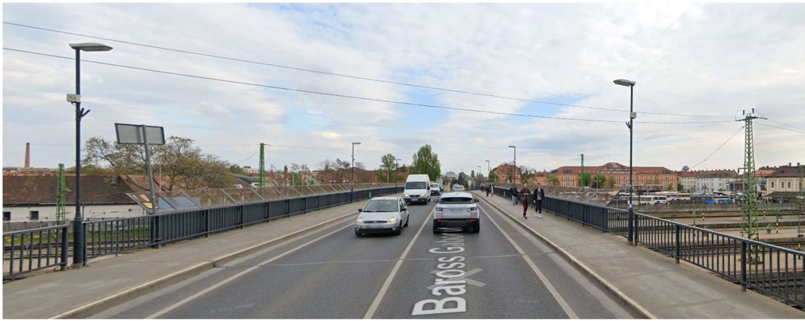
3. Baross híd (forrás: Google maps)
